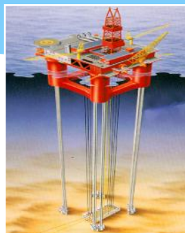
Платформы на натяжных опорах
