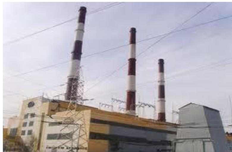
**Проект «Расширение Кызылской ТЭЦ».** Строительство новой очереди котельного цеха с установкой двух котлоагрегатов, нового турбинного цеха с установкой четырех турбогенераторов. Суммарная мощность расширения IV очереди составит 48 МВт электрической, 300 Гкал/час тепловой энергии.
