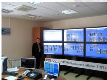
➤ АРМ «Энергоэффективность» (компонент автоматизированных систем технического и коммерческого учета) объектов нефтегазодобычи и др.
