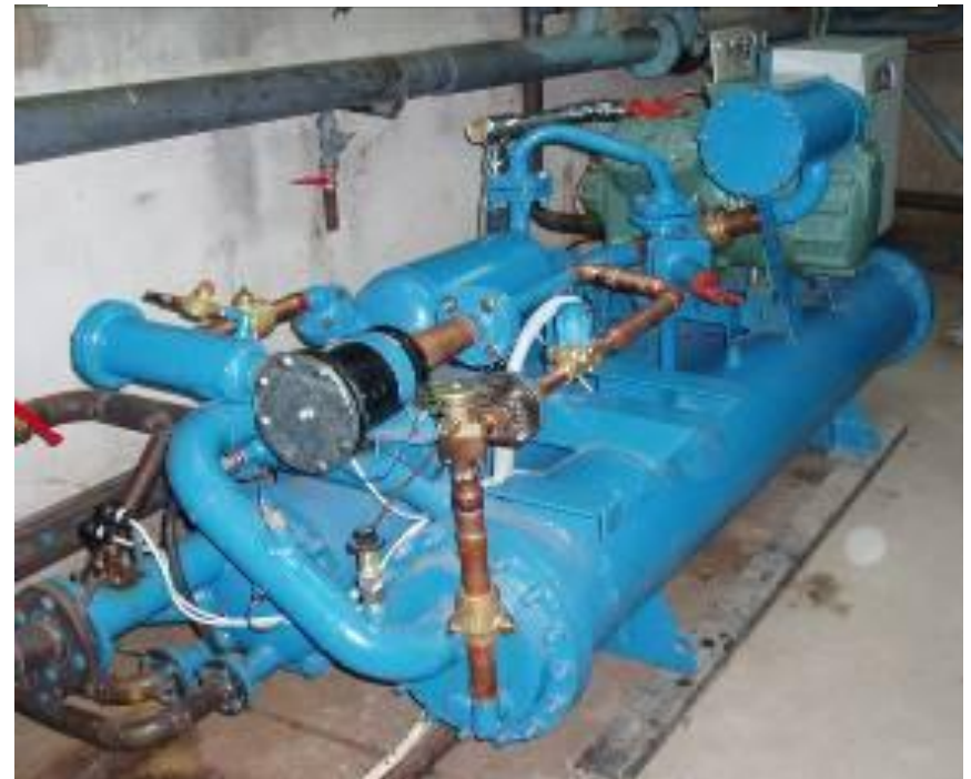
Парокомпрессионный тепловой насос HT60-1 в схеме отопления Байкальского музея ИНЦ СО РАН (ИТ СО РАН, ВТК «Икар»)
